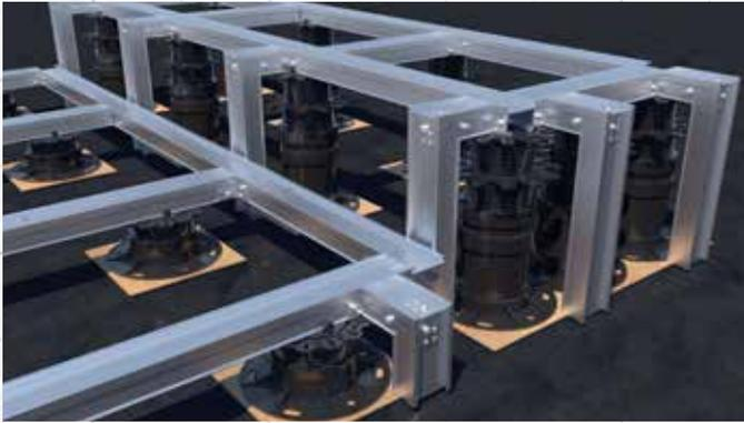
**2** **Abschlussprofil Alu-Unterkonstruktion unten** (975640) in die gewünschte Länge bringen und mit der Unterkonstruktion verschrauben.
