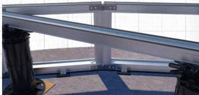
**5** Holzverkleidung mit der **Profilbohrschraube** an den Seiten anbringen.
