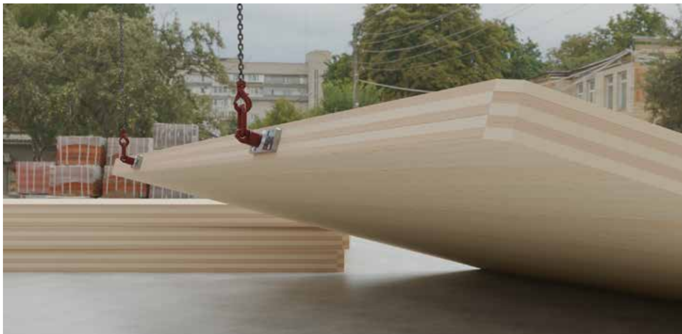
Anwendung Powerblock Transportanker
