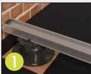
1 Fixieren Sie das Bauteil 2 des StarterClips auf der Oberseite der Terrassenunterkonstruktion.
