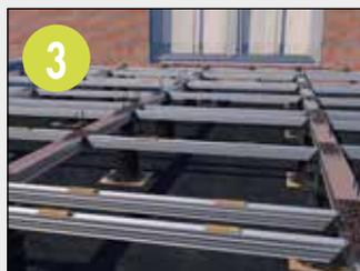
Die Schienen gleichmäßig verteilen, sodass die Steinplatten optimal unterstützt werden. Mit der mitgelieferten Aluminium Profilbohrschraube Ø 4,2 x 35 fixieren.
