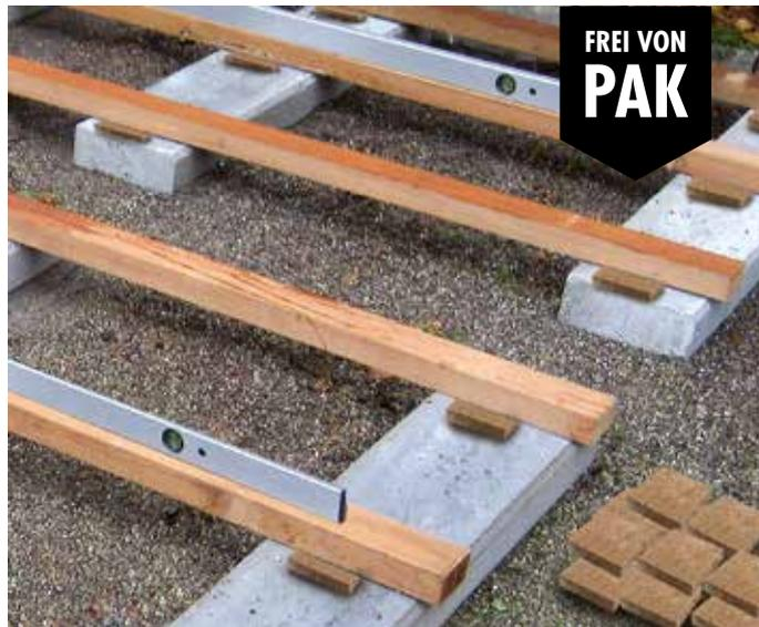
Die Kork-Pad Abstandhalter werden zwischen die Terrassenunterkonstruktion und das Fundament / den Untergrund gelegt und bilden so einen Abstand, der dem konstruktiven Holzschutz dient. Die Kork-Pad Abstandhalter stehen in drei verschiedenen Stärken zur Verfügung (3, 6 und 10 mm).
