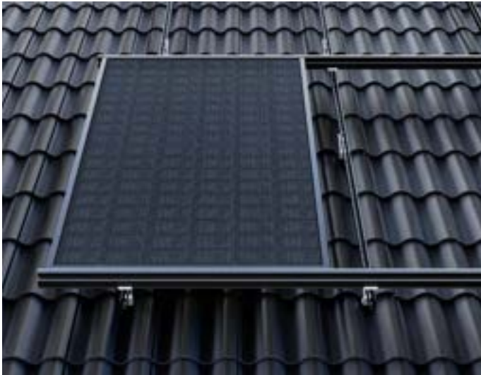
SCHRITT 16: Fertig eingesetztes Solarmodul
