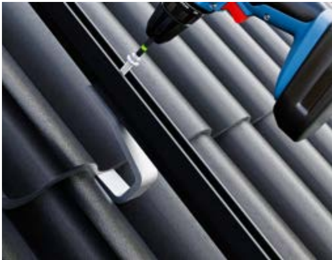
SCHRITT 5: Jetzt wird das Basisprofil LayTec mithilfe der Fixierschraube LayTec auf den Dachhaken LayTec geschraubt.
