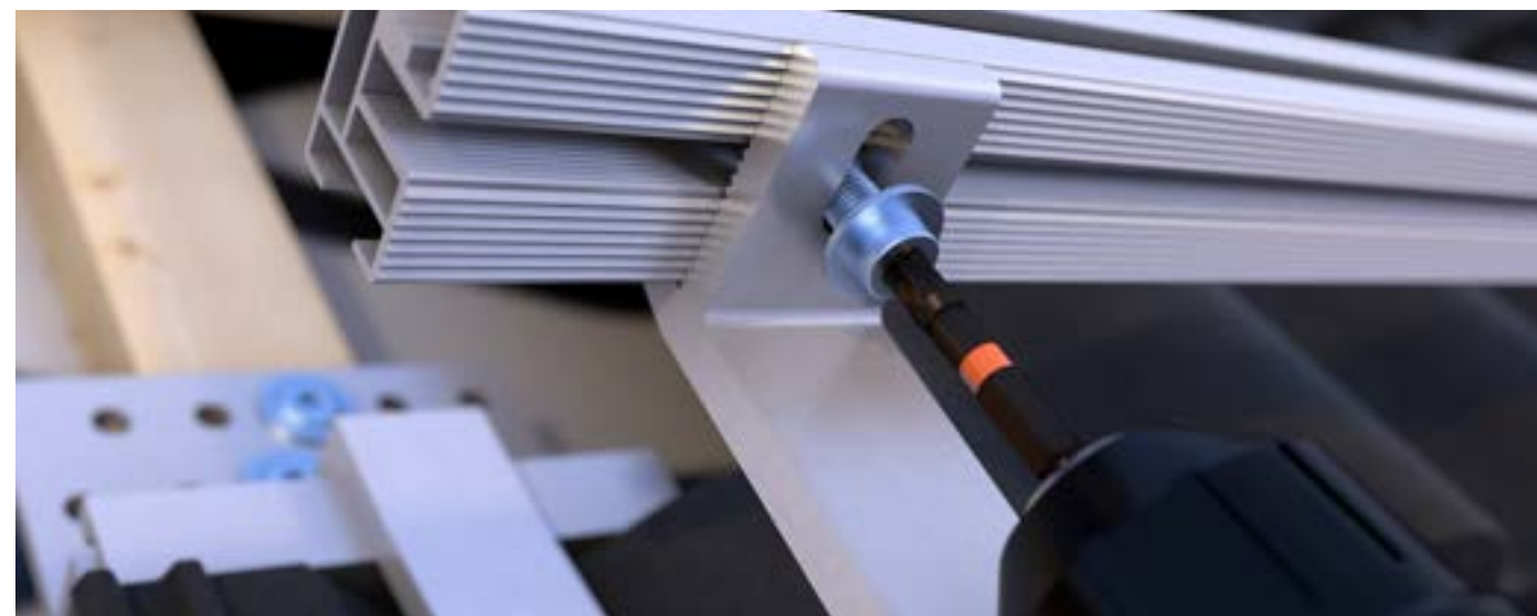
SCHRITT 3: Das Montageprofil FIX-FIT bequem einlegen und mit der Fixierschraube FIX-FIT befestigen.
