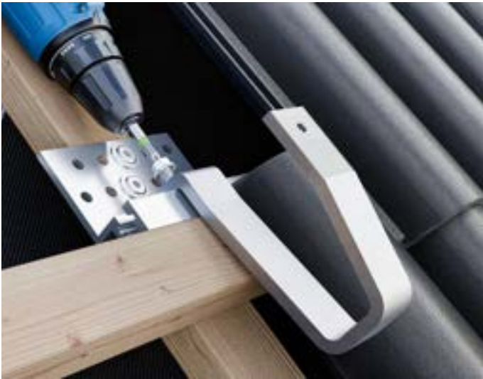
SCHRITT 2: Als nächstes wird der Dachhaken in die richtige Position gebracht und arretiert.
