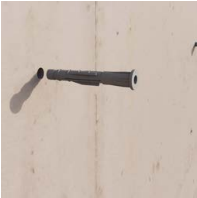
SCHRITT 2: Dübel einsetzen.
