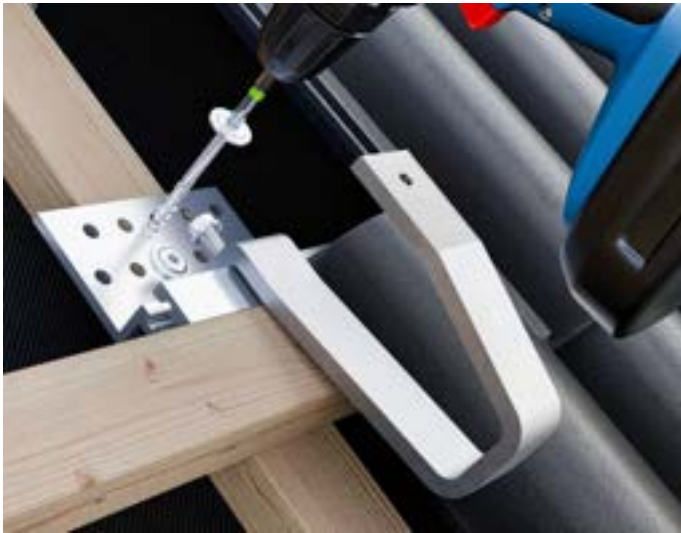
SCHRITT 1: Hier wird der Dachhaken LayTec an die Konterlatte geschraubt.
