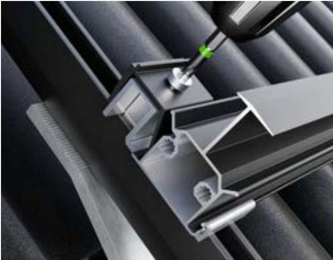
SCHRITT 12: Als nächstes wird das Einlegeprofil mit der Schraube des Profilverbinders arretiert.
