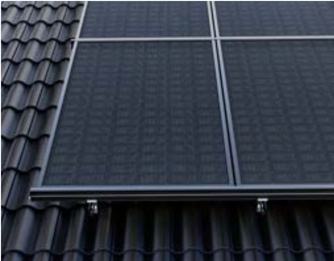
SCHRITT 21: Nachdem alle Solarmodule eingesetzt und die Enkappen montiert sind, ist das Einlegesystem LayTec vollständig aufgebaut.
