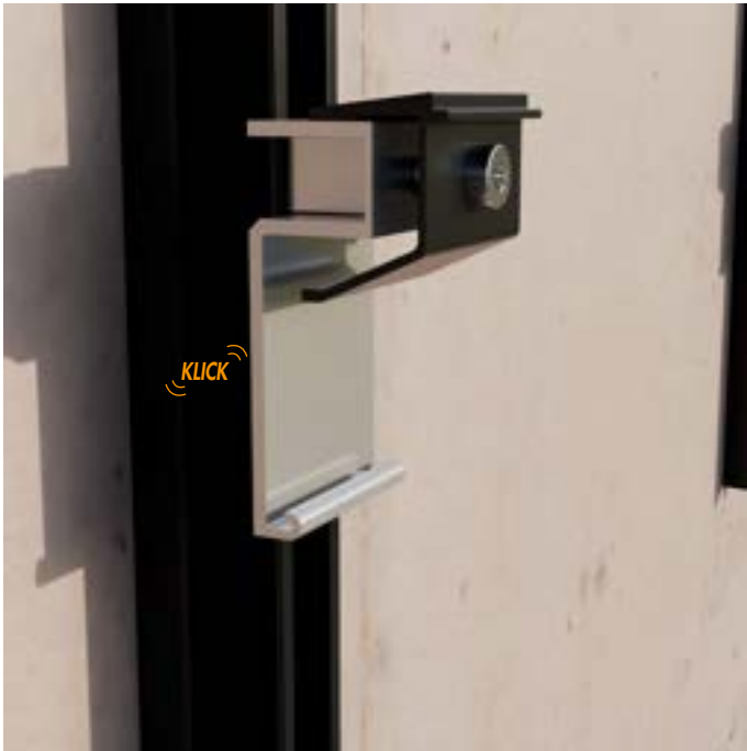
SCHRITT 4: Profilverbinder in Basisprofil einklicken.
