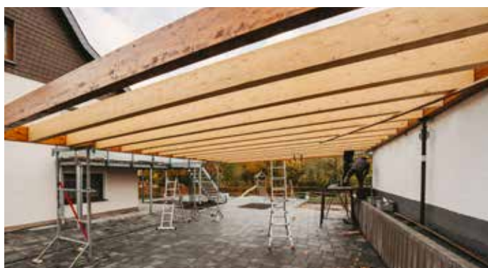
Anwendungsbeispiel der KonstruX im Carportdach.
