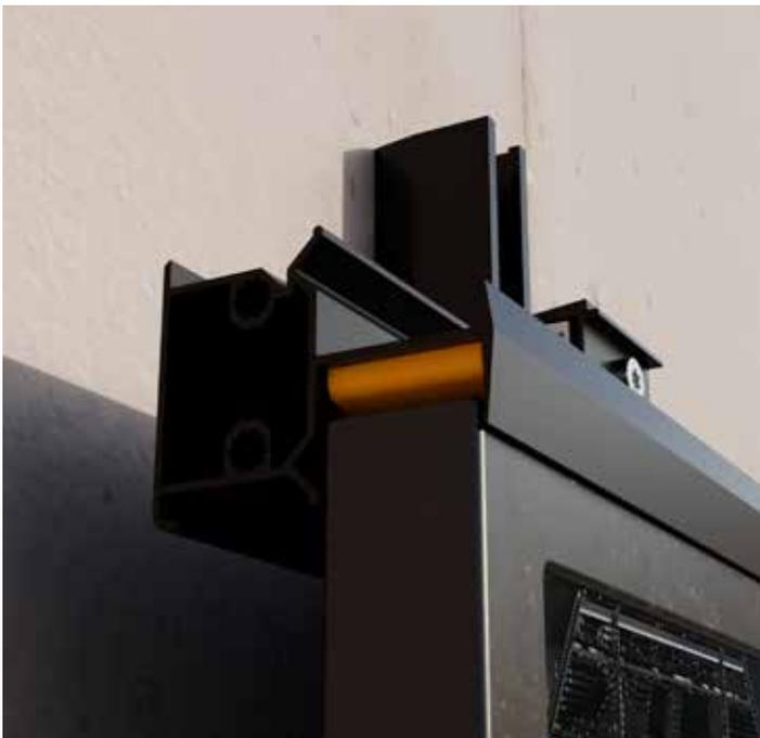
**SCHRITT 12:** Für Randbereiche den Stift am Abstandshalter an den vorgesehenen Sollbruchstellen abbrechen. Den vorbereiteten Abstandshalter anschließend, wie in Schritt 11 beschrieben, hinter das Modul klemmen. (Hinweis: Die orange Farbe dient lediglich der Darstellung; der Abstandshalter ist in der Ausführung schwarz.)
