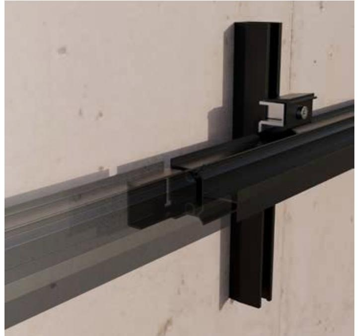
**OPTIONALER SCHRITT 6.2:** Zur Verlängerung des Einlegeprofils einfach den Längsverbinder Einlegeprofil in das erste Profil einschieben und das zweite Profil aufschieben. **Wichtig:** Die Verlängerung dient ausschließlich zur Führung und ersetzt keinen Befestigungspunkt.
