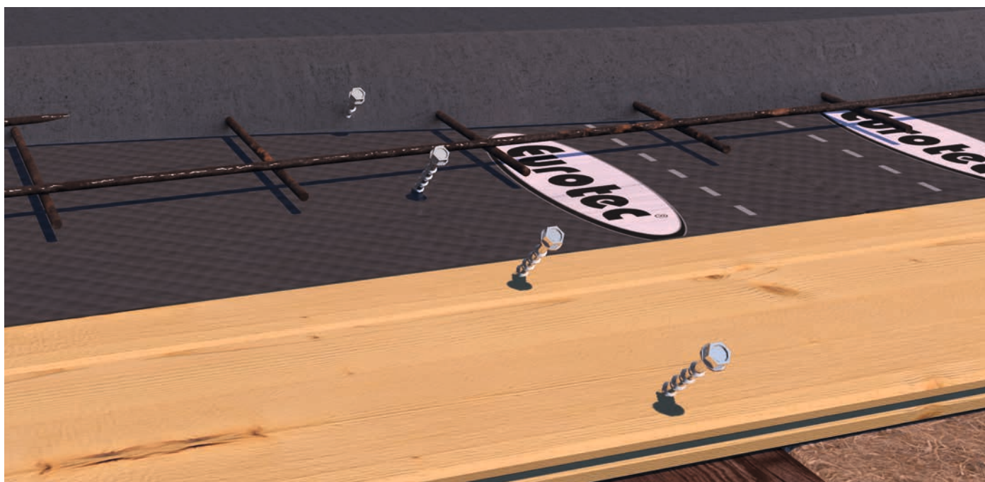
Aislamiento contra impactos y contrapiso en el forjado de CMH
