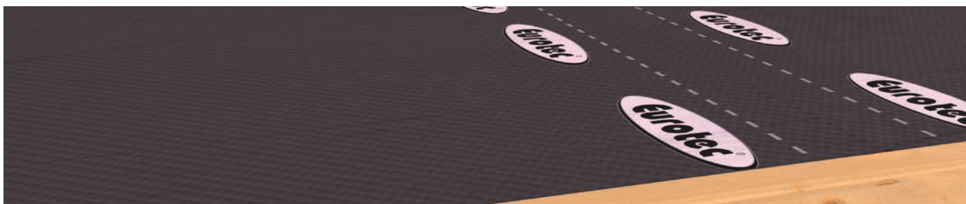
Membrana y encofrado del forjado existente
