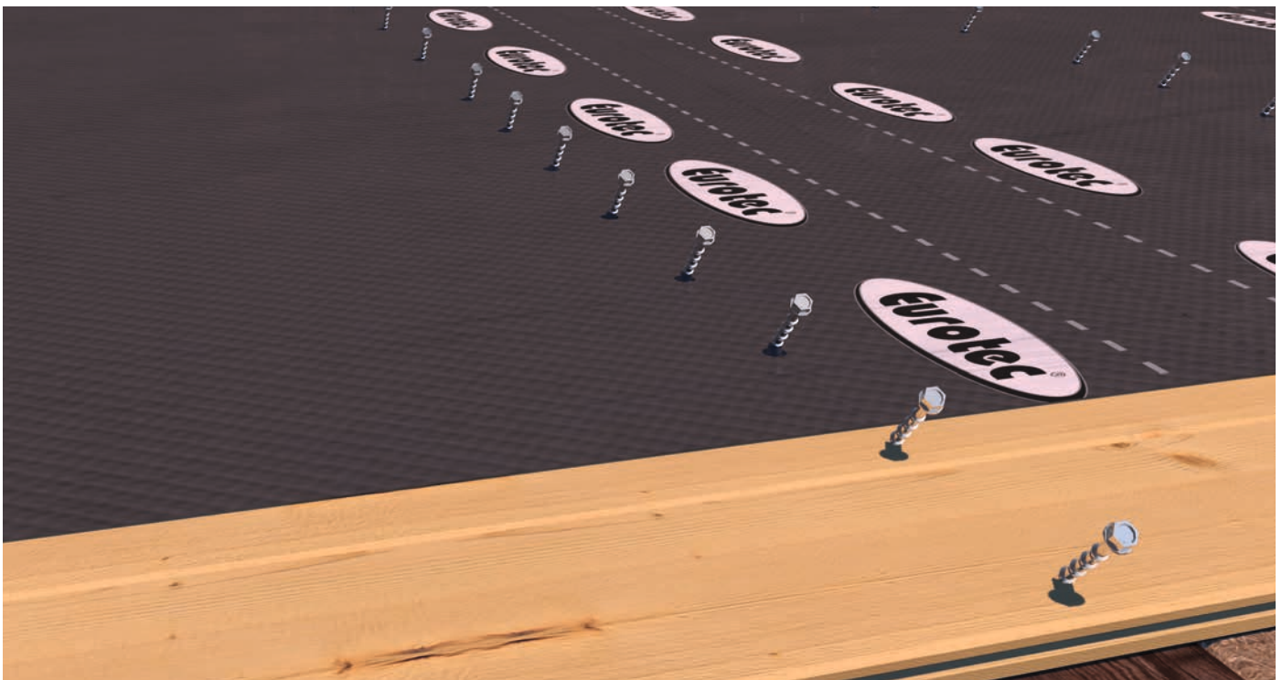
Instalación de los conectores en el forjado existente
