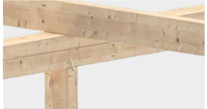
Fissaggio di supporti nelle strutture di telai in legno
