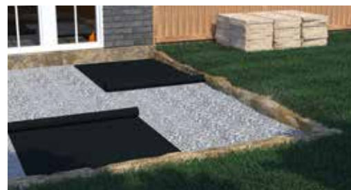
Esempio di applicazione sottofondo geotessile
