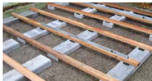
Distanziale Rolphi in combinazione con sottostruttura in legno.
