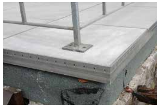
Esempio di applicazione profilo terminale del balcone
