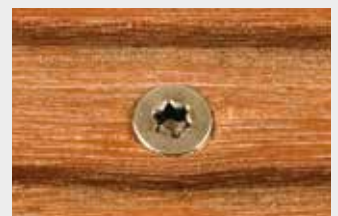
Preforatura + vite Terrassotec
