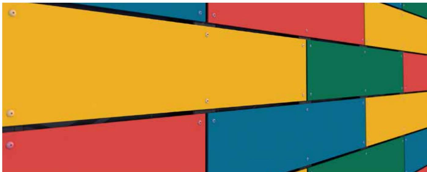
Tableros laminados (HPL) fijados con tornillos de fachada en el color correspondiente a juego.
