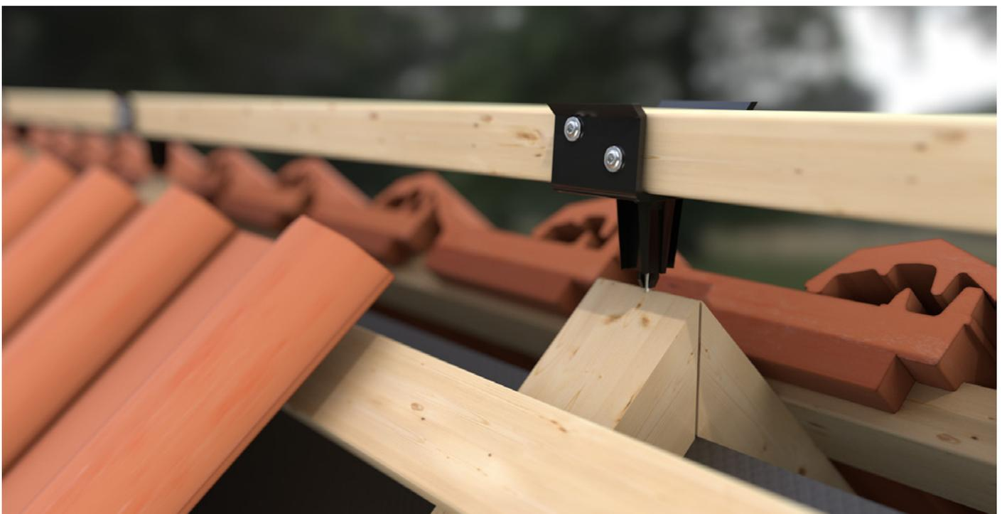
Exemple de montage du support d'arêtier et de latte faitière 50
