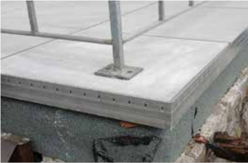
Exemple d'application profilé de finition du balcon
