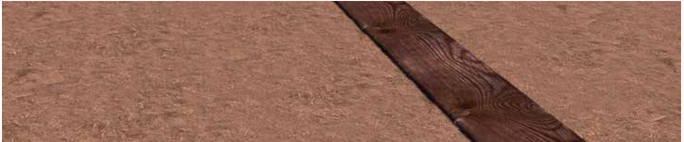
Dämmung der Bestandsdecke
