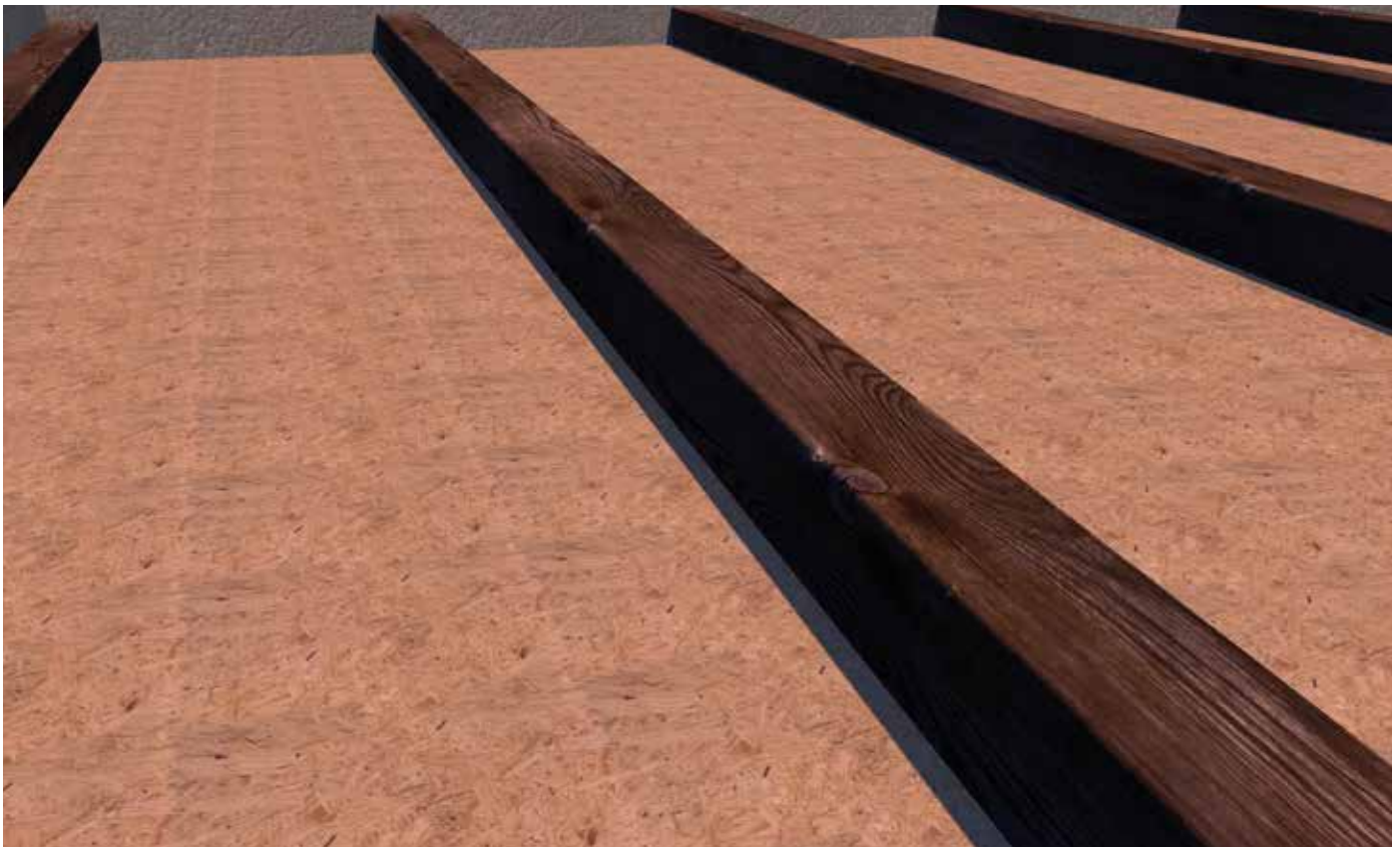
Rückbau einer Bestandsdecke
