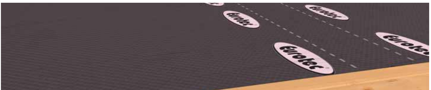
Schalung und Folie auf der Bestandsdecke
