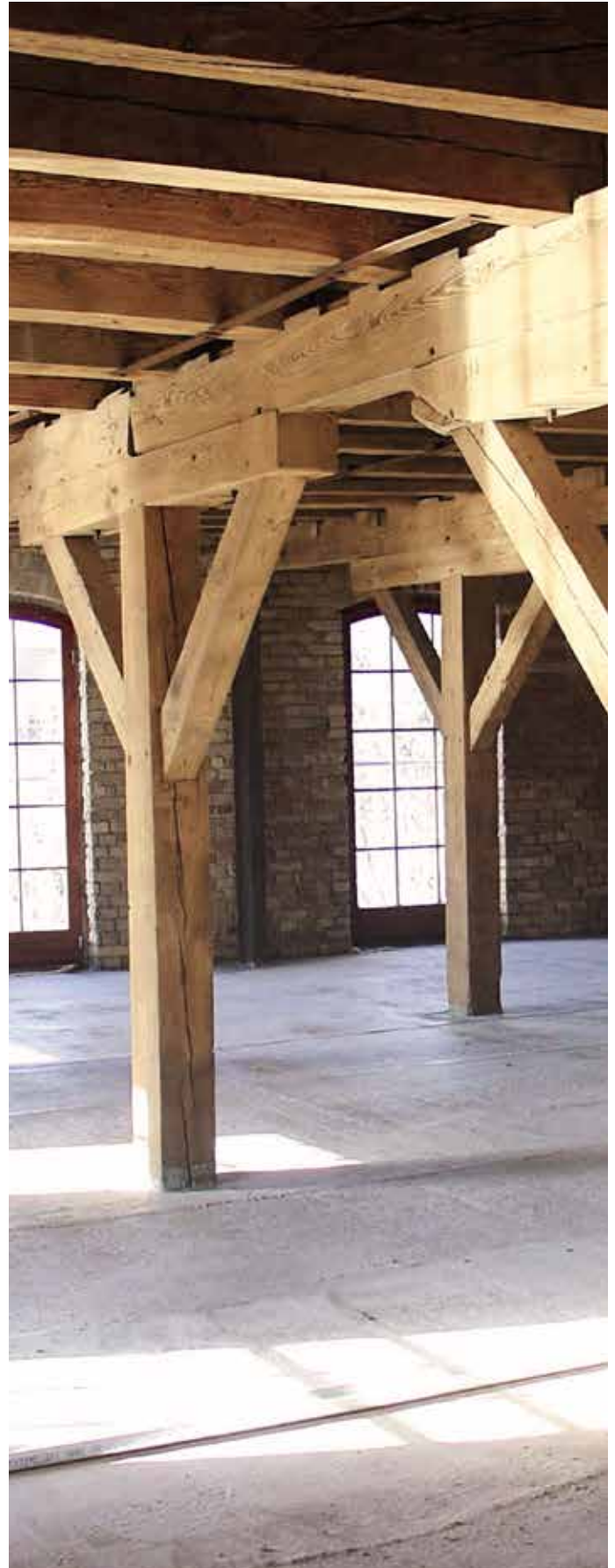
Innenansicht eines Hauses mit alter Holzbalkendecke
