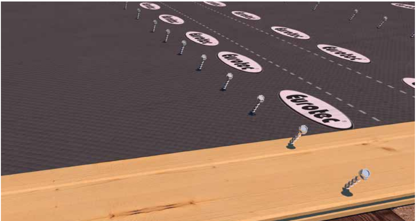
Montage der Verbinder auf der Bestandsdecke
