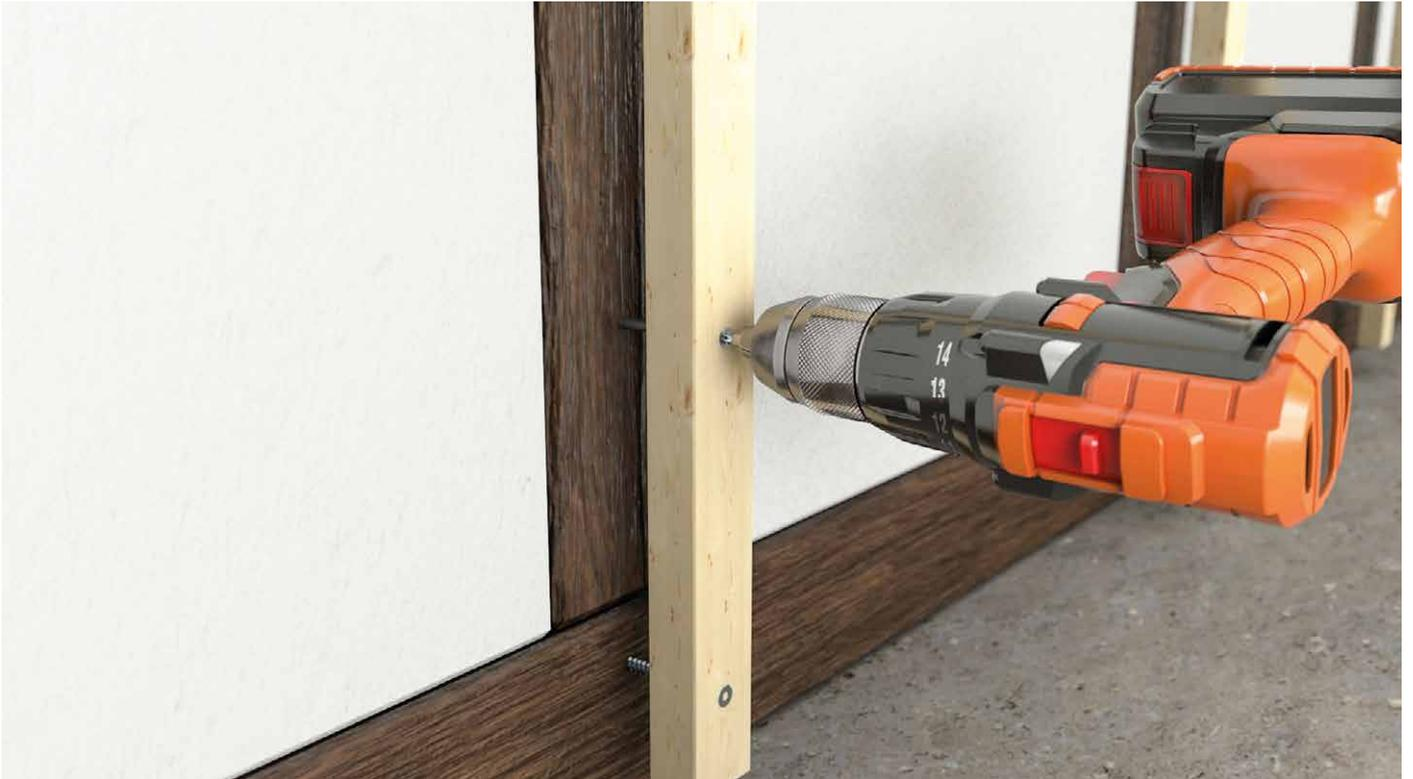
*Schnelles Ausrichten einer Unterkonstruktion mit der Justitec.*
