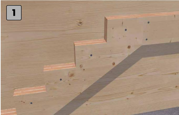
Stufenauflage an der Wand anbringen.
