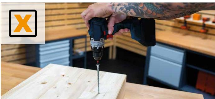
Üben Sie während der Installation **nicht zu viel Druck aus**, da dies schlanke Schrauben verformen kann, sodass das gewünschte Ergebnis nicht erreicht wird.
