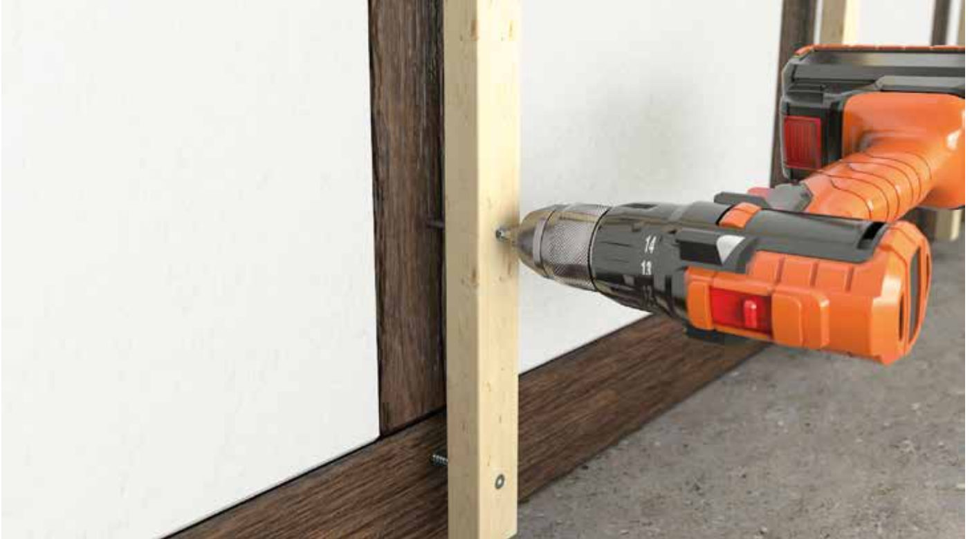
Alineación rápida de una subestructura con el Justitec.
