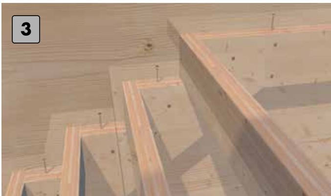
Fijar los peldaños a la parte superior del soporte de peldaños.
