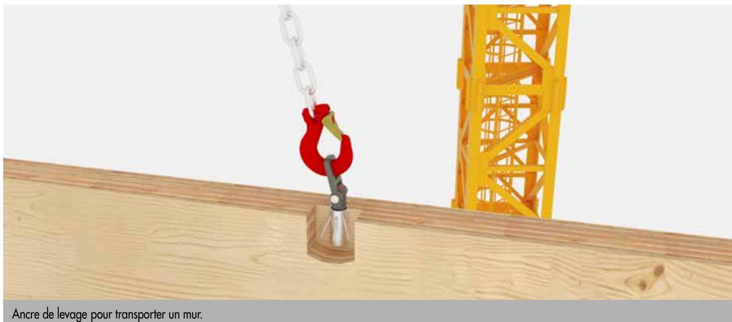
Ancre de levage pour transporter un mur.
