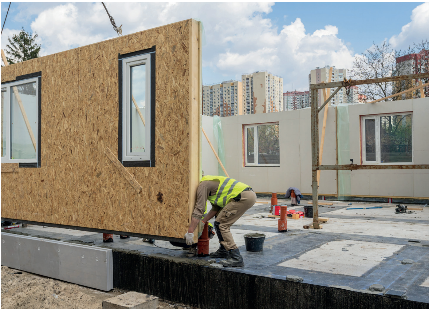
Montage der vorgefertigten Wandelemente auf der Baustelle
