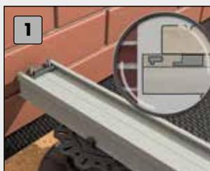
Fixez le composant 2 du StarterClip sur la face supérieure de la structure porteuse de la terrasse.
