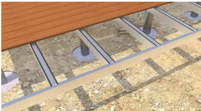
**6** La dernière étape consiste à poser les finitions latérales. Pour ce faire, on colle au préalable, sur les faces extérieurs du **profilé de support HKP**, de la bande pour **façade en EPDM**. Ensuite, on fixe par-dessus les planches de bois de son choix à l'aide de **vis de forage pour profilé**.
