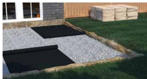
Exemple d'application couche de support en géotextile
