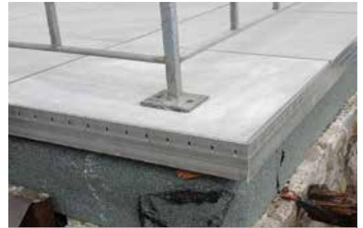
Exemple d'application profilé de finition du balcon
