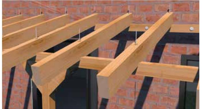
**5** Les bois profilés sont positionnés, en commençant par le bas et en direction de la façade de la maison, puis fixés aux poutres de toit à l'aide de vis Panelwistec SK.
