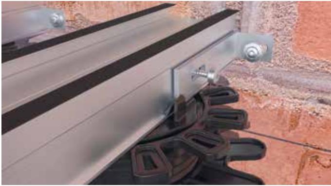
11 Mocowanie elementów bocznych.
