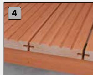
4 Questo sistema di fissaggio è adatto esclusivamente a tavole per terrazze con scanalatura laterale.
