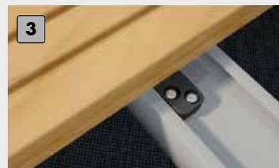
3 Fissare l'elemento scorrevole per terrazze dall'alto nella sottostruttura.
