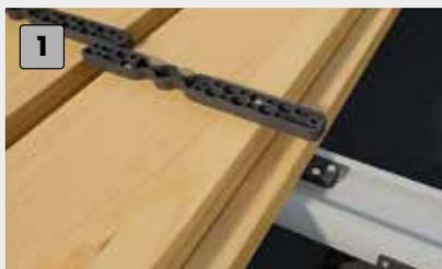
1 Fissare l'elemento scorrevole per terrazze sul lato inferiore delle tavole, prestare attenzione al contrassegno dell'elemento scorrevole.
