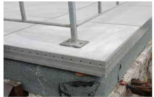
Esempio di applicazione profilo terminale del balcone
