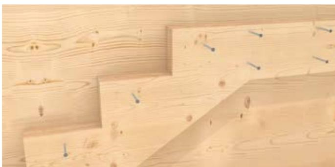
KonstruX DUO zum Bau einer Treppenunterkonstruktion
