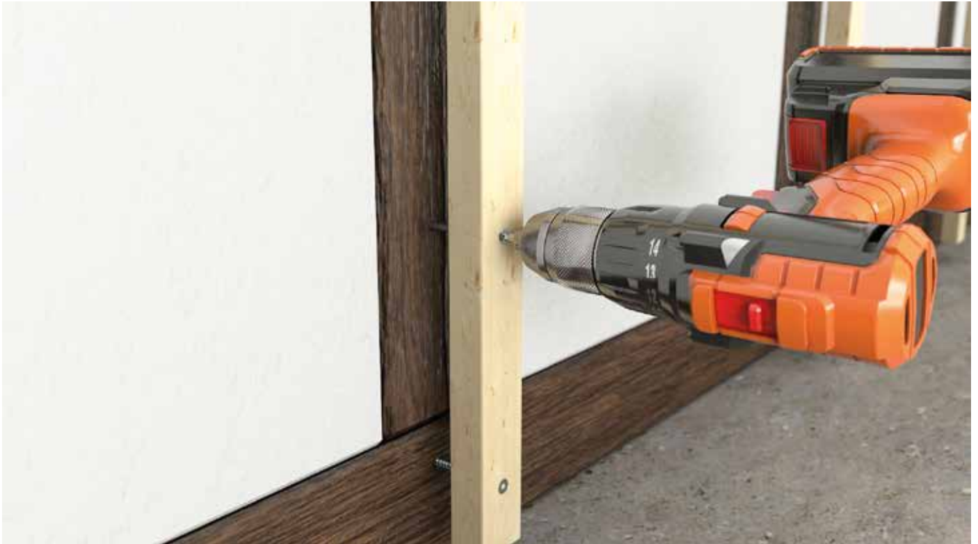
Schnelles Ausrichten einer Unterkonstruktion mit der Justitec.
