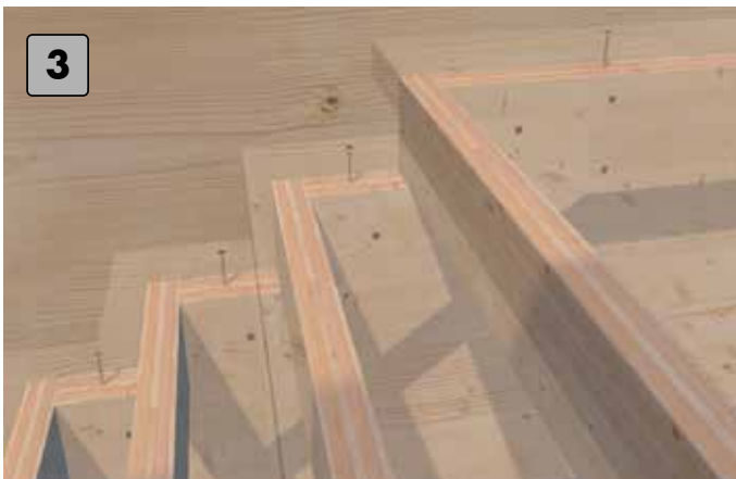
Stufen oben auf der Stufenauflage anbringen.
