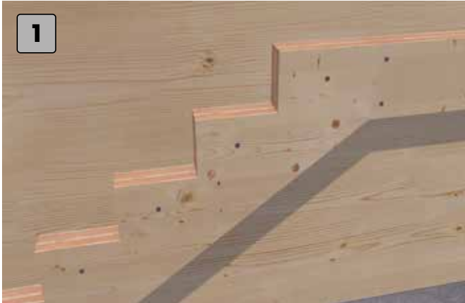
Stufenauflage an der Wand anbringen.
