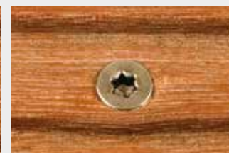
Forage préalable + vis Terrassotec
