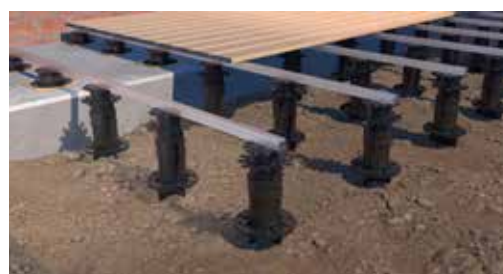
Élargissement de fondations de terrasse avec le tirant d'ancrage FLEXI.
