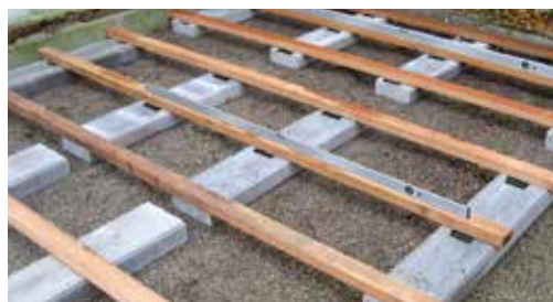
Écarteur Rolfi en combinaison avec une structure porteuse en bois.
