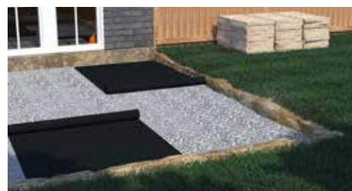
Ejemplo de aplicación de manta
