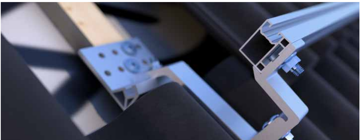
Montageprofil Steildach SLIM an Dachhaken FLEX SLIM mittels Hammerkopfschraube und Sperrzahnmutter befestigt.
