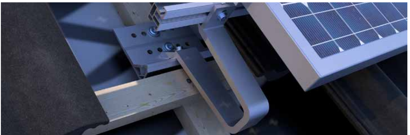
Dachhaken FIX-FIT-DN 2 an der Konterlatte montiert, durch die ausgeklinkte Dachpfanne geführt und mit montiertem Montageprofil FIX-FIT.
