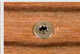
Forage préalable + vis Terrassotec
