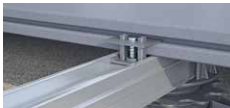
Niewidoczne mocowanie deski drewnianej za pomocą uchwytu systemowego EVO Light.
