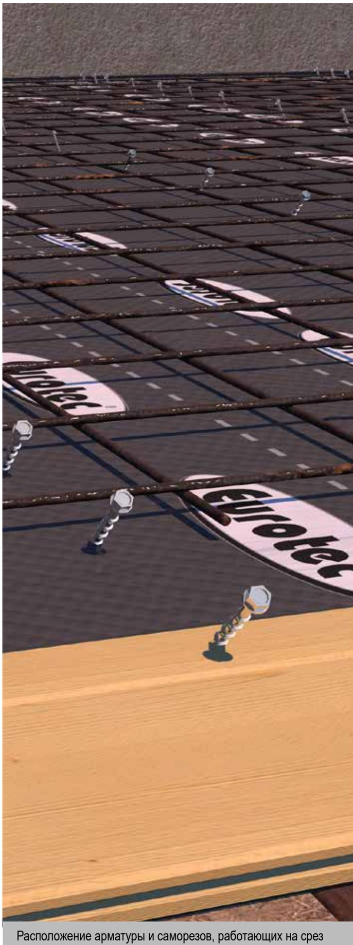
Расположение арматуры и саморезов, работающих на срез
