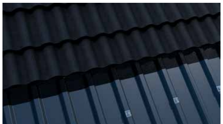
SCHRITT 12: Obere Dachpfannen anpassen und einsetzen.
