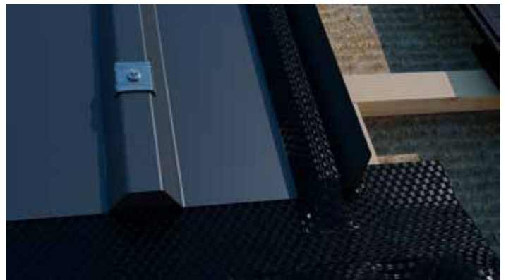
SCHRITT 10: Kehldichtstreifen befestigen.
