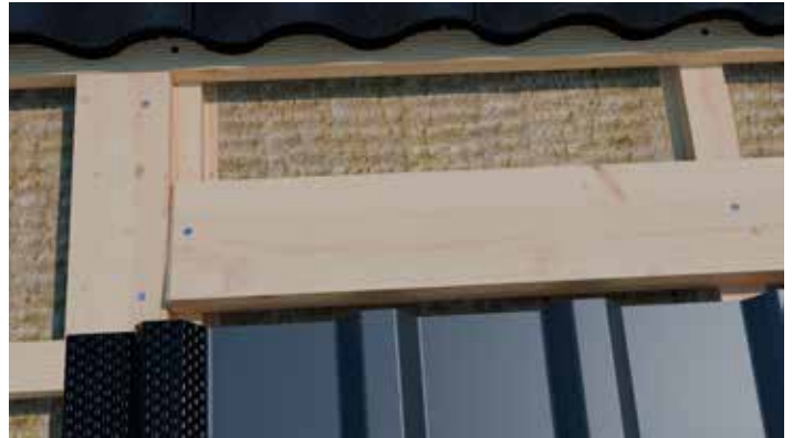
SCHRITT 8: Obere Keilbohle montieren.
