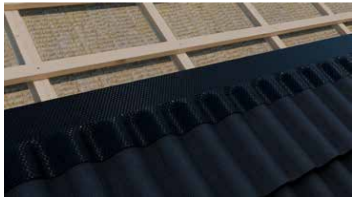
SCHRITT 4: Wandanschlussband befestigen.
