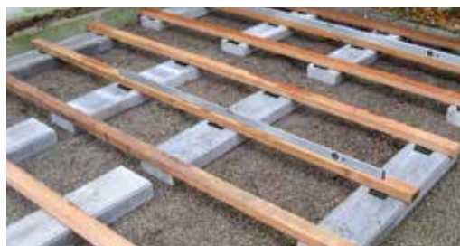
Soporte distanciador Rolfi en combinación con subestructura de madera.
