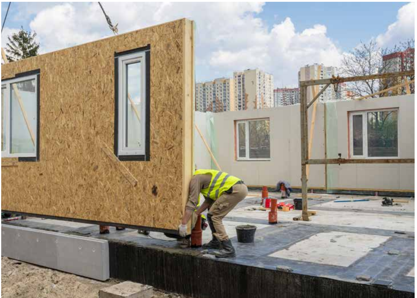
Montage der vorgefertigten Wandelemente auf der Baustelle
