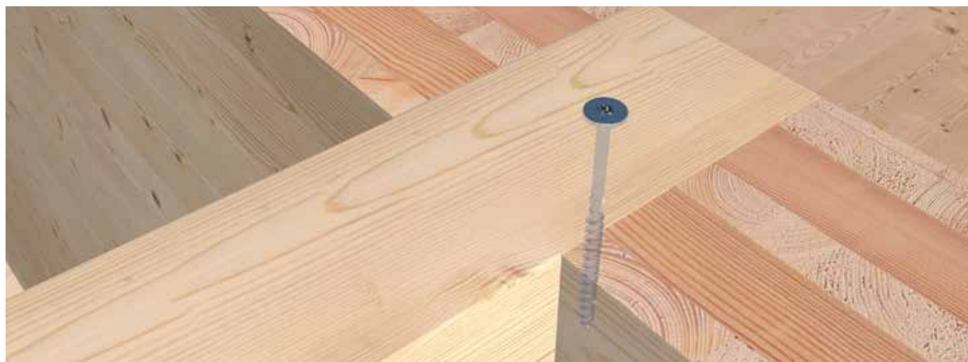
Un travetto viene fissato alla parete in CLT sganciata tramite la vite a filettatura parziale SawTec.
