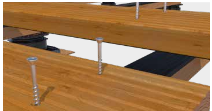
Die Hapatec, Heli A4 wird in den Terrassenbelag aus Itaúba verschraubt.
