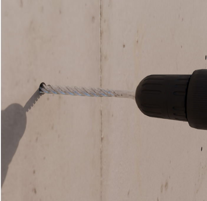
SCHRITT 1: Bohrlöcher für Dübel vorbohren. Pro Basisprofil sind zwei Bohrlöcher erforderlich.
