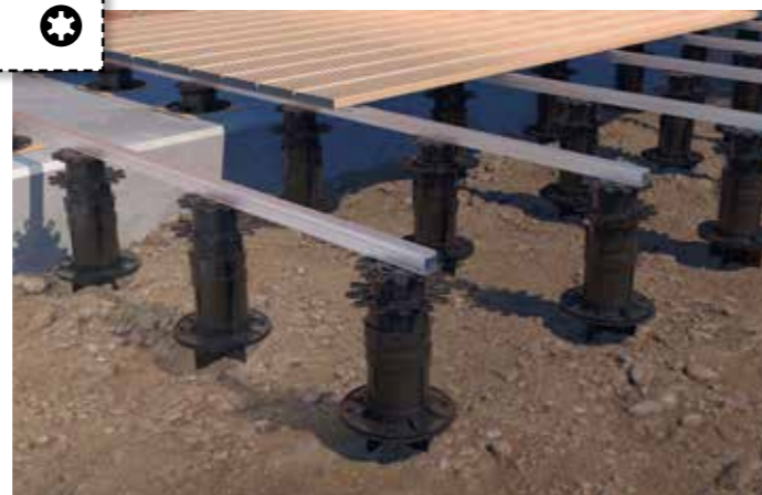
Erweiterung eines Terrassenfundaments mit dem Erdanker FLEXI.
