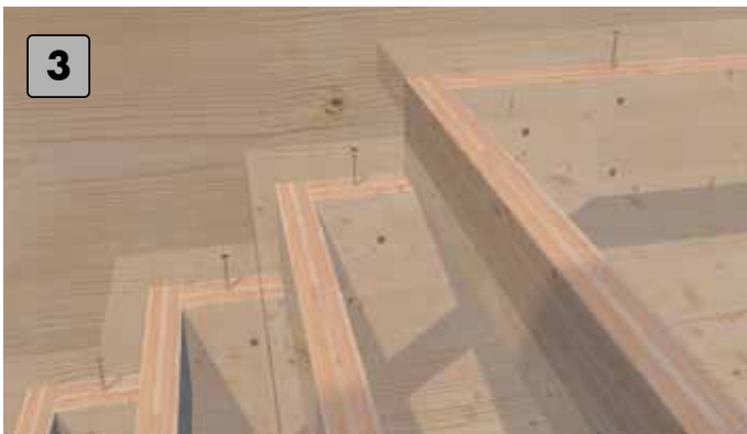
Posizionare i gradini superiori all'appoggio dei gradini.
