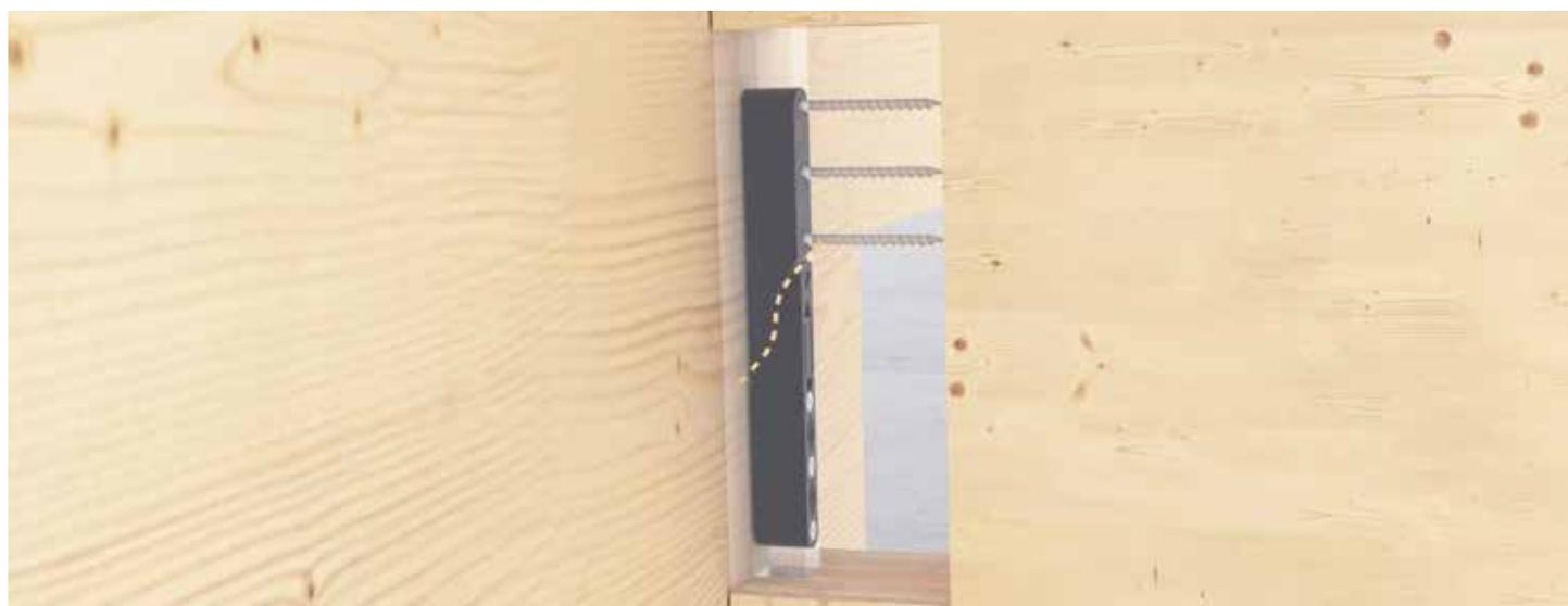
Conector de montaje utilizado para unir una nueva pared, a una pared previamente posicionada.
