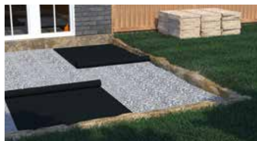
Esempio di applicazione sottofondo geotessile
