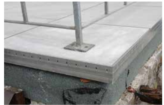
Esempio di applicazione profilo terminale del balcone
