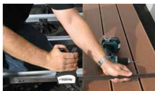
Esempio di applicazione morsetto
