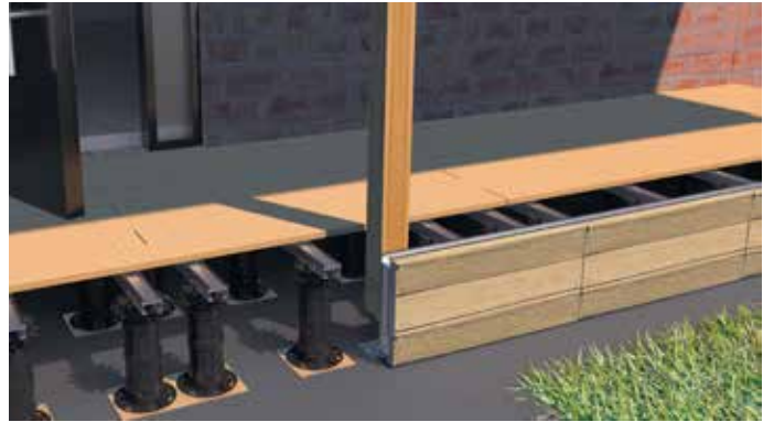
12 Le tavole per terrazze vengono posate parallelamente alla facciata dell'edificio. Si parte con le prime tavole vicino alla facciata dell'edificio. Nel nostro esempio abbiamo scelto un fissaggio a vista e le tavole sono avvitate ai profili modulari in alluminio EVO con la vite auto perforante per profili Eurotec . Come ausilio consigliamo il Drill-Stop , i distanziatori e i morsetti .
