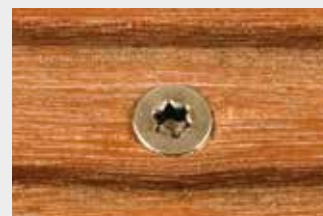
Preforatura + vite Terrassotec
