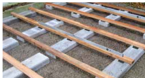
Distanziale Rolfi in combinazione con sottostruttura in legno.
