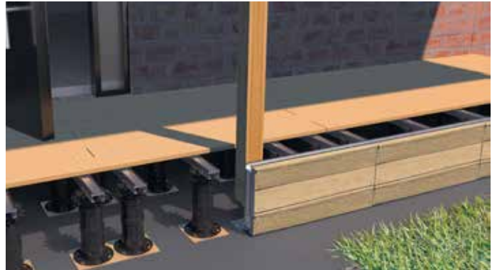
12 Deski tarasowe są układane równoległe do elewacji domu. Zaczyna się na elewacji domu od pierwszej deski. W naszym przykładzie wybraliśmy widoczne mocowanie, aby przykręcić deski za pomocą profilowej śruby samowiercącej Eurotec do aluminiumowych profili systemowych EVO . Jako środek pomocniczy zalecamy Drill Stop , klocki dystansowe i ścisk mocujący.
