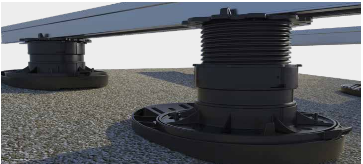
Wyrównanie spadku za pomocą Nivello 2.0.
