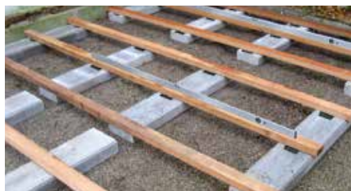
Uchwyty dystansowe Rolfi w połączeniu z drewnianą konstrukcją nośną.
