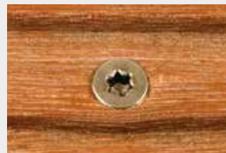
Wstępne nawiercanie + wkręt Terrassotec
