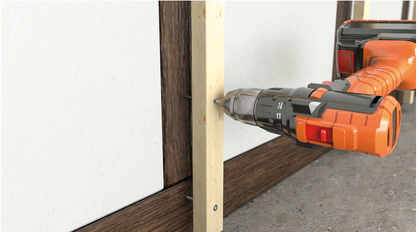
Szybkie ustawianie podkonstrukcji za pomocą wkrętu Justitec.
