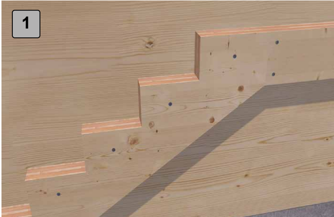
Zamontować wspornik stopni na ścianie.
