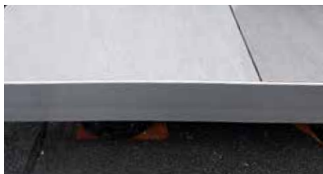
Esempio di applicazione: Pannello terminale per balconi
