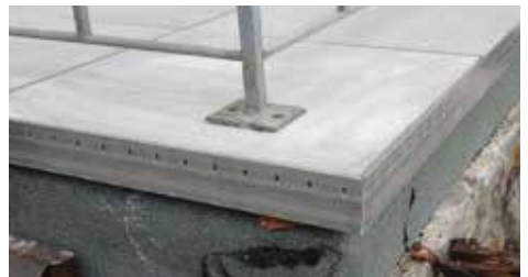
Esempio di applicazione: Profilo perimetrale per balconi
