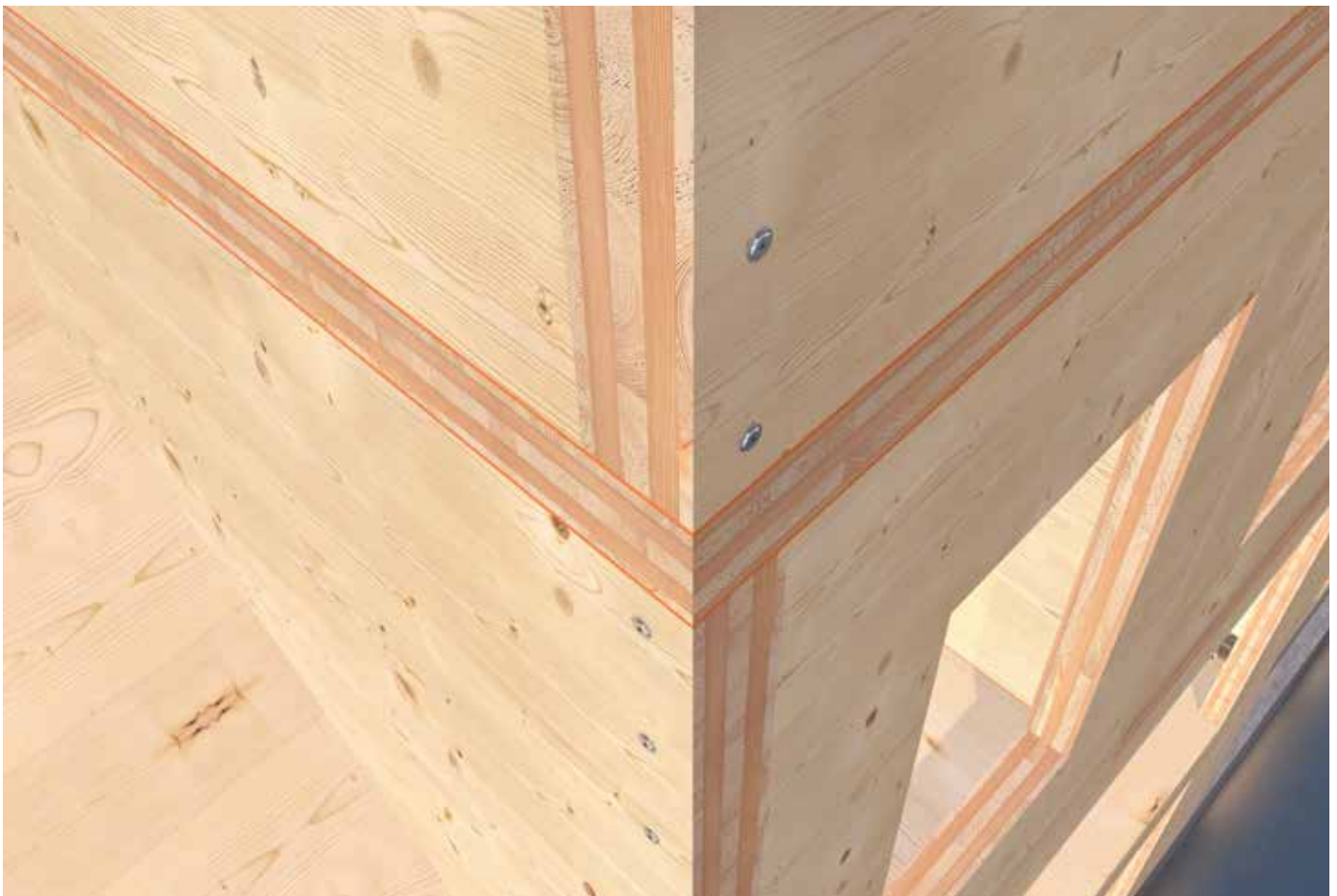
Paneltwistec testa larga per il collegamento a vite di pareti.
