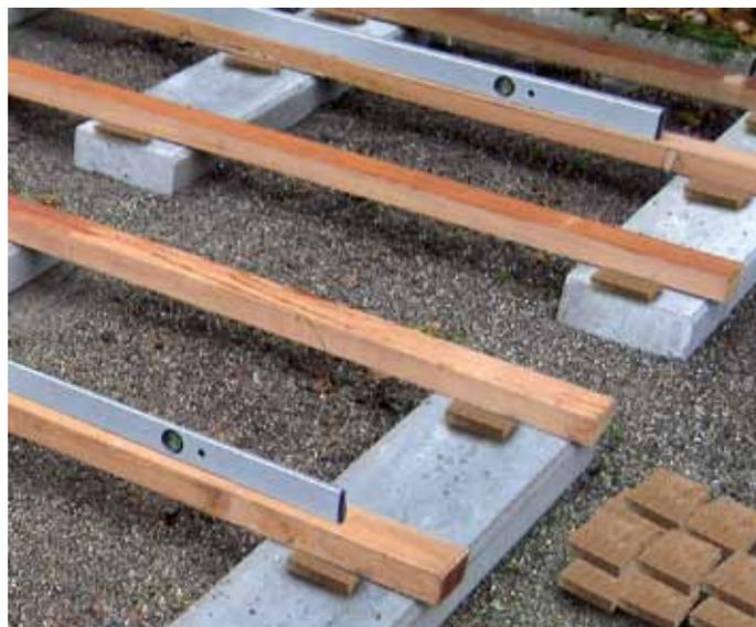
I distanziatori Kork-Pad (con un lato autoadesivo) vengono inseriti tra la struttura di supporto e la fondazione o la base, garantendo così la distanza adatta a garantire una protezione strutturale del legno. I distanziatori Kork-Pad sono disponibili in tre differenti spessori/ altezze: 3 mm, 6 mm e 10 mm (vedere fig.).
