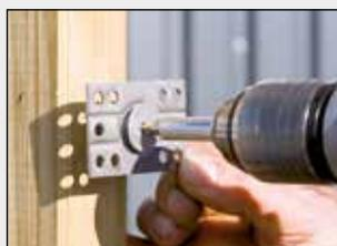
Avvitare l'elemento di fissaggio per graticci con una vite per graticci applicata anteriormente sul pannello del graticcio. Consigliamo di utilizzare almeno 2 elementi di fissaggio per ogni lato, ovvero 4 elementi di fissaggio per ogni pannello del graticcio.
