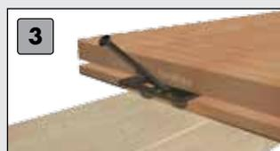
3 Fissare la Decking Clip nel punto in cui è stata eseguita la perforazione inserendo la vite attraverso la Decking Clip. Eseguire lo stesso procedimento su ogni trave per ogni asse.
