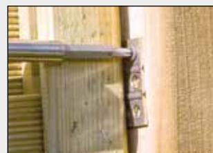
Fissare quindi il pannello del graticcio sul montante in legno utilizzando un elemento di fissaggio. Consigliamo di usare 4 viti Clickyfix per ogni elemento di fissaggio.
