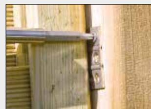
Fissare quindi il pannello del graticcio sul montante in legno utilizzando un elemento di fissaggio. Consigliamo di usare 4 viti Clickyfix per ogni elemento di fissaggio.
