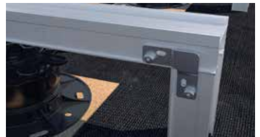
Przykład zastosowania łącznik 90° do profili
