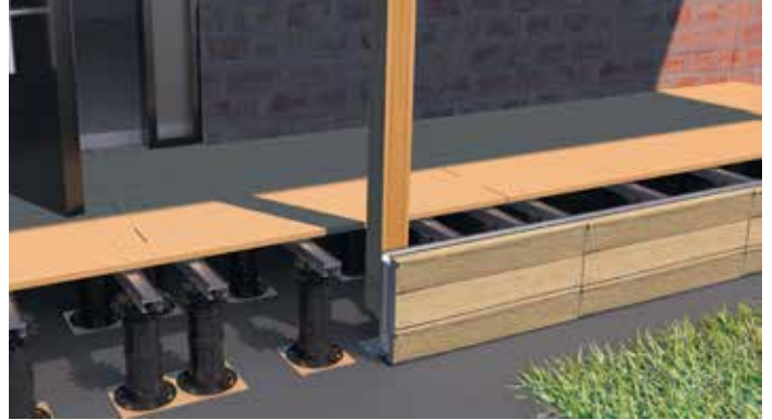
12 Deski tarasowe są układane równolegle do elewacji domu. Zaczyna się na elewacji domu od pierwszej deski. W naszym przykładzie wybraliśmy widoczne mocowanie, aby przykręcić deski za pomocą profilowej śruby samowiercącej Eurotec do alumi- niowych profili systemowych EVO . Jako środek pomocniczy zalecamy Drill Stop , klocki dystansowe i ścisk mocujący.
