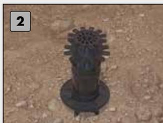
2 Una vez instalado por completo en el suelo, posicione el plot regulable sobre el plato de la cabeza del anclaje.
