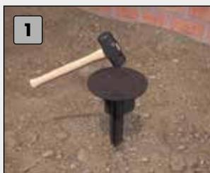
1 Instale el anclaje al suelo utilizando un martillo.
