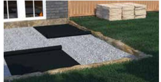
Ejemplo de aplicación de manta geotextil
