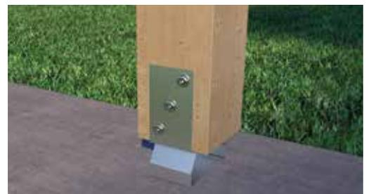
Ejemplo de aplicación del portapilar en U atornillado
