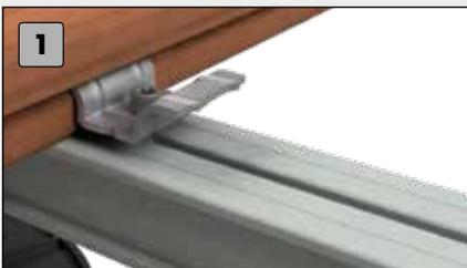
1 Posicione el Clip-V y atornille levemente con el tornillo de 4,2 x 25 mm.
