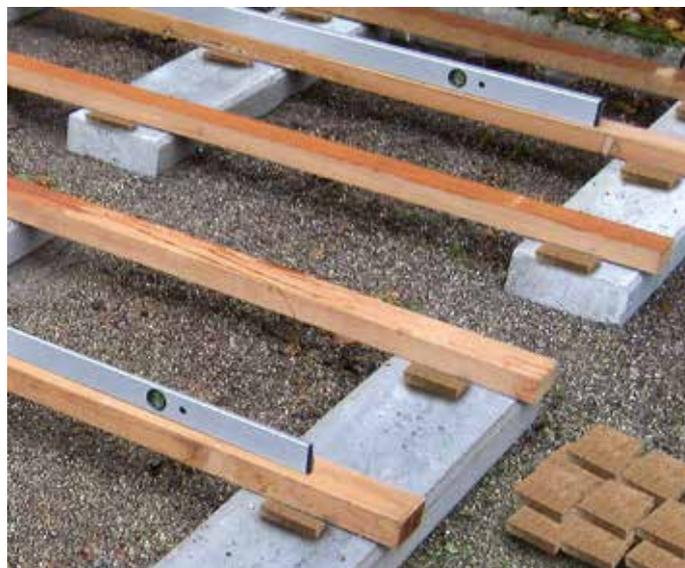
Las almohadillas distanciadoras de corcho se colocan entre la subestructura de las terrazas y la cimentación/la base. De esa manera, se crea una distancia que sirve para proteger la madera de construcción. Las almohadillas distanciadoras de corcho se encuentran disponibles en tres diferentes grosores (3, 6 y 10 mm).
