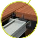
**4** Bei sichtbarer Befestigung: Dielen einzeln von oben mit Schrauben in den Alu-Profilen befestigen.
