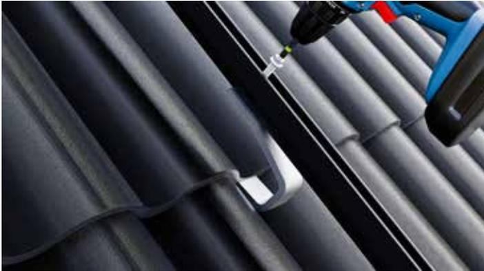
**SCHRITT 7:** Jetzt wird das Basisprofil LayTec mithilfe der Fixierschraube LayTec auf den Dachhaken LayTec geschraubt.
