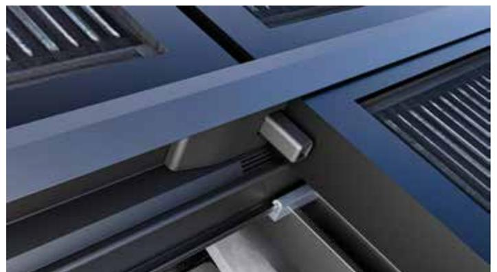
**SCHRITT 23:** Zwischen jedem Solarmodul wird in der oberen Einlegeschiene ein Abstandhalter LayTec eingesetzt. Dieser verhindert, dass das Solarmodul wieder nach oben heraus kann und schafft automatisch einen Abstand von 10 mm zwischen den Solarmodulen.
