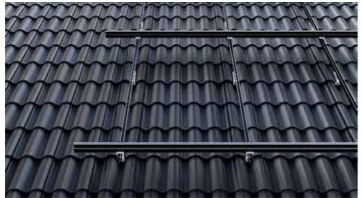
**SCHRITT 16:** Dieser Vorgang wird mit den nächsten Einlegeschielen wiederholt. Abstand zwischen den Einlegeprofilen: Solarmodul + 8 mm.
