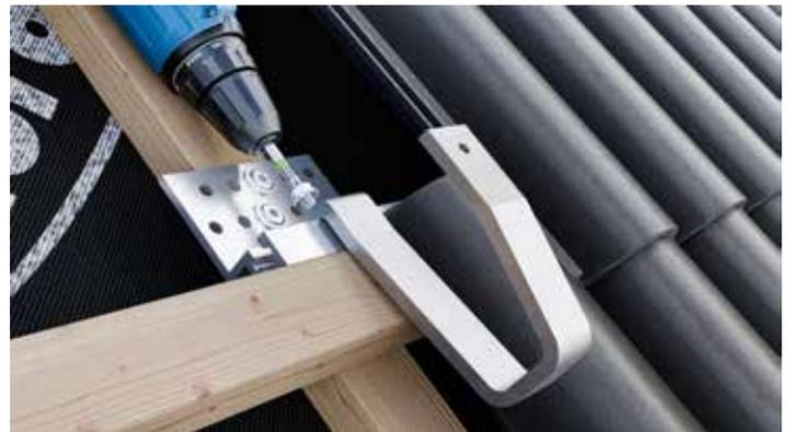
**SCHRITT 4:** Als nächstes wird der Dachhaken variabel in die richtige Position gebracht und arretiert.
