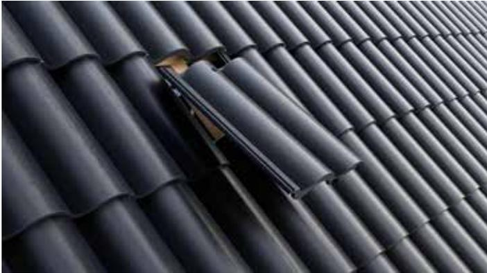
**SCHRITT 1:** Im ersten Schritt wird die Dachpfanne vom Dach gelöst.
