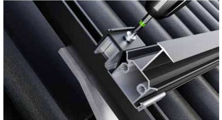
**SCHRITT 14:** Nachdem das Profil waagrecht und mit dem richtigen Abstand zum nächsten Profil ausgerichtet wurde, können die Schrauben der Profilverbinder angezogen werden, wodurch alles arretiert wird. Abstand zwischen den Einlegeprofilen: Solarmodulhöhe + 8 mm.
