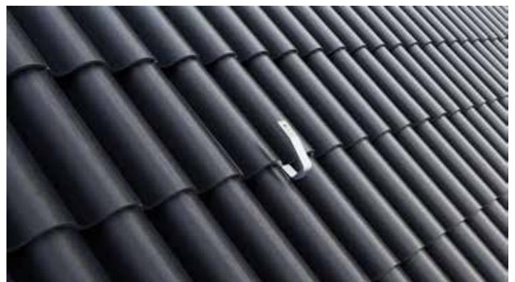
**SCHRITT 6:** Dachhaken LayTec im montierten Zustand.
